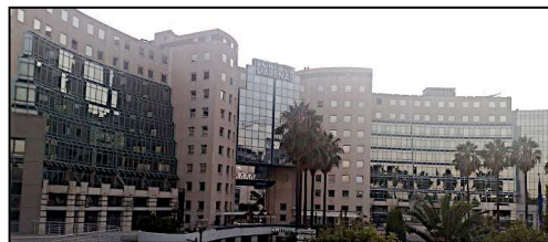
Fig. 3. Immeuble contenant le bureau
