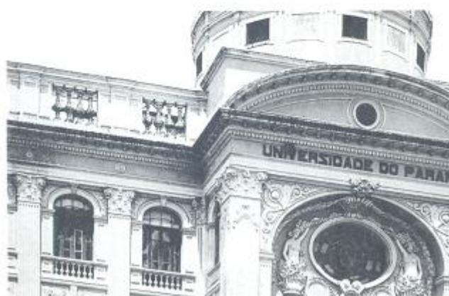
Detalhe do edifício.
