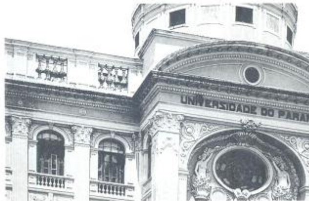
Detalhe do edifício.
