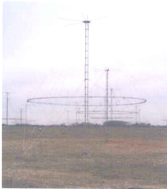
Antenne réseau de NOSTRADAMUS
